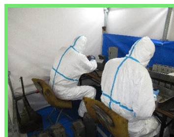
減容化作業実施
